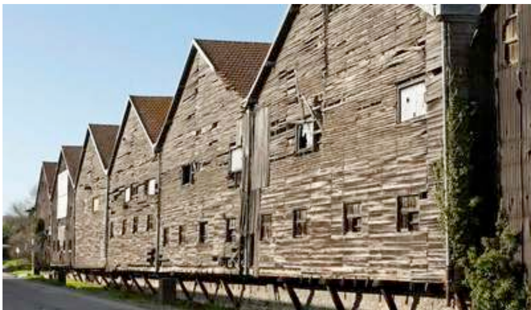
Honfleur – Usine de fibre de bois puis de menuiserie Duchesne
